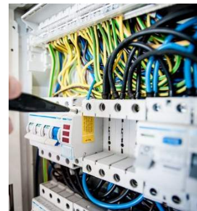
Оборудование для электромонтажа
