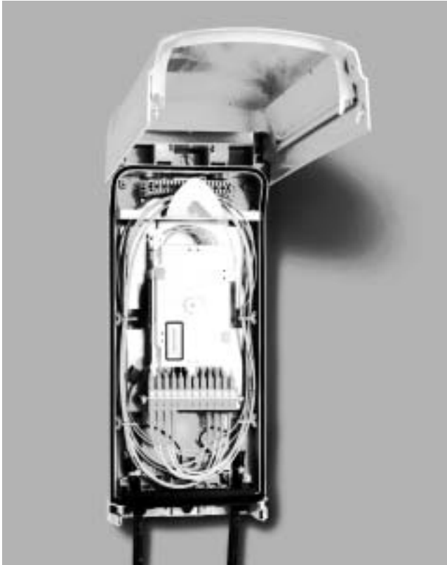
1 - UniBox IV 2 - оптические переходные элементы 3 - модули оптических соединителей 4 - основание (входит в комплект поставки оптического адаптера)
